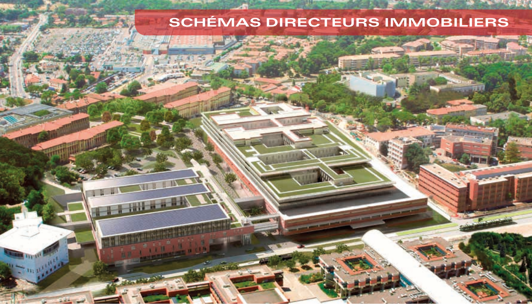
CHU Toulouse - Vue aérienne site Purpan
