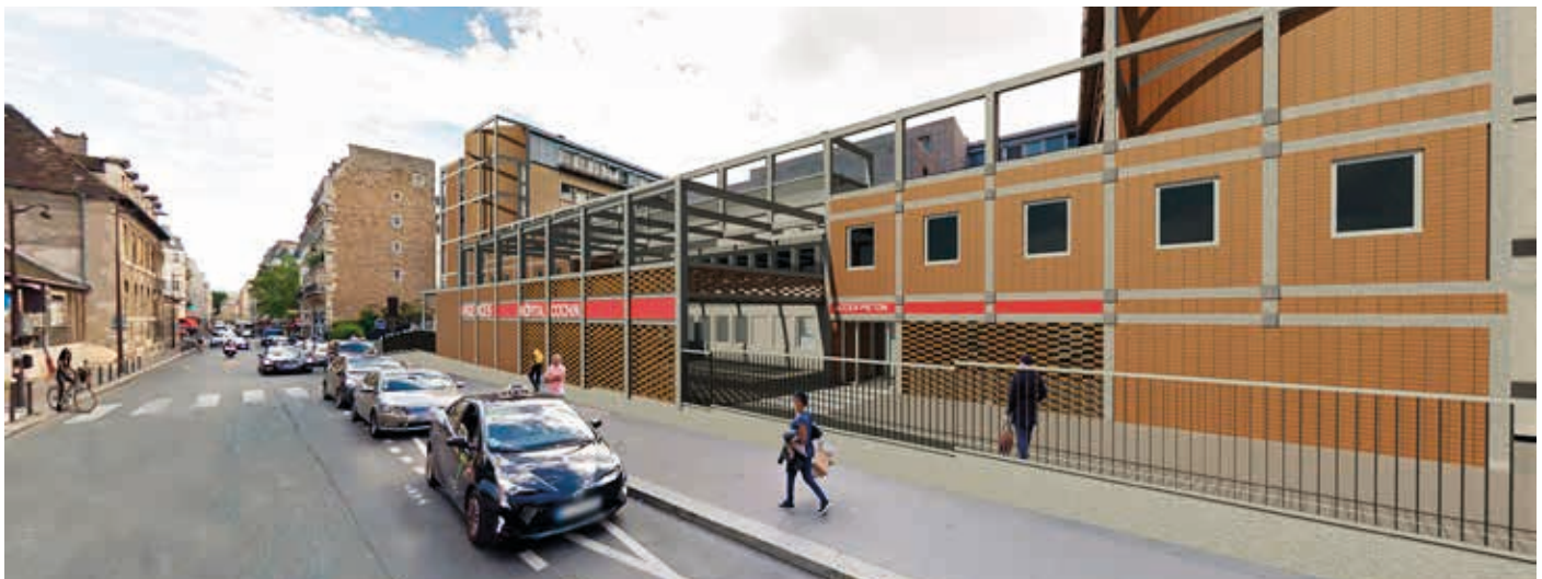
In-Fine réalise une restructuration complète des urgences de l'hôpital Cochin (AP-HP) à Paris, comprenant 2 secteurs de soins de 17 boxes, une unité de surveillance rapprochée (6 places), un pôle hospitalisation courte durée (15 lits) et un service radiologie. Livraison 2019.
