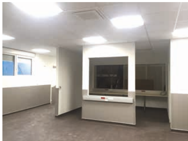
Hôpital Ambroise Paré IRM 3 Tesla
