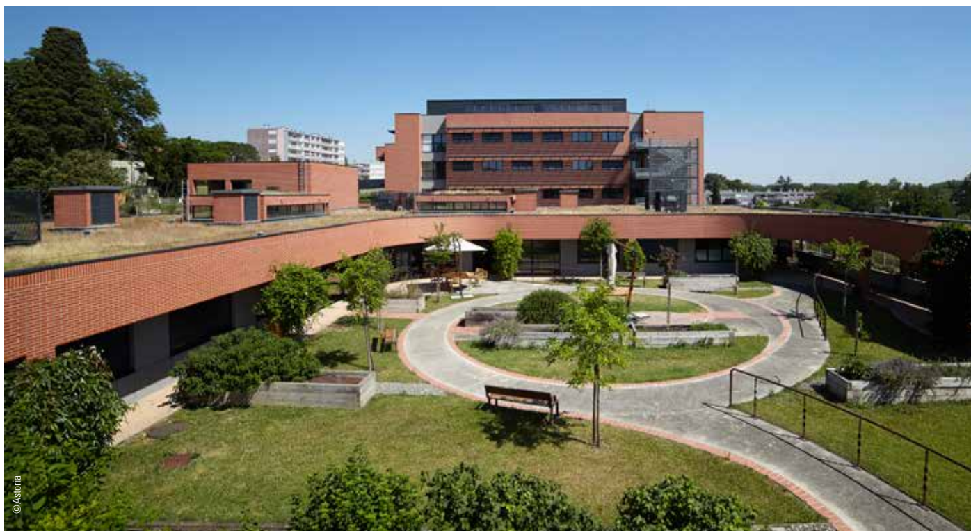
CHU de Toulouse – Hôpital Garonne – Démarche HQE
