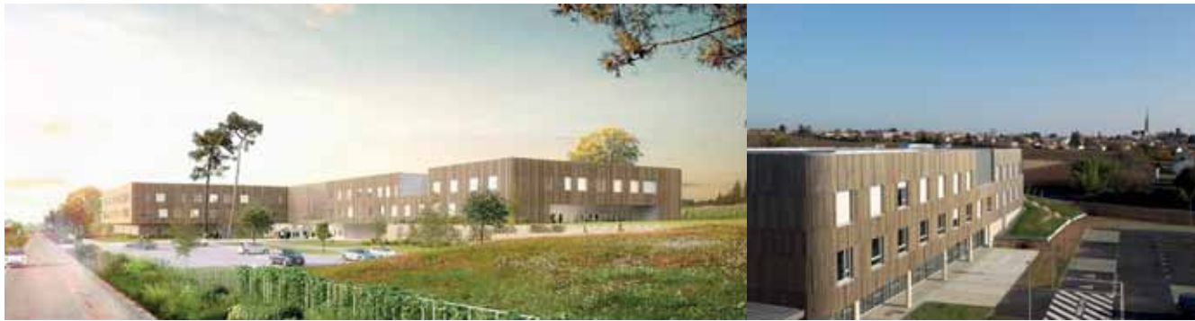
Centre Hospitalier SEVRE ET LOIRE (44) - Restructuration du site du Loroux-Bottereau (194 lits) dont 107 lits EHPAD – Moe AIA Life Designer
