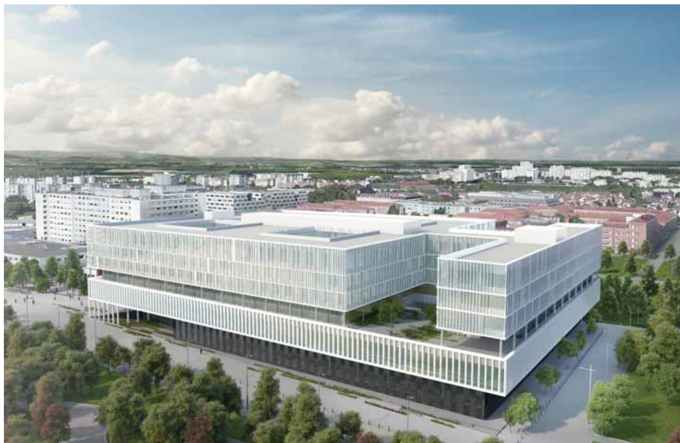
Nouvel hôpital de REIMS | © Groupe-6
