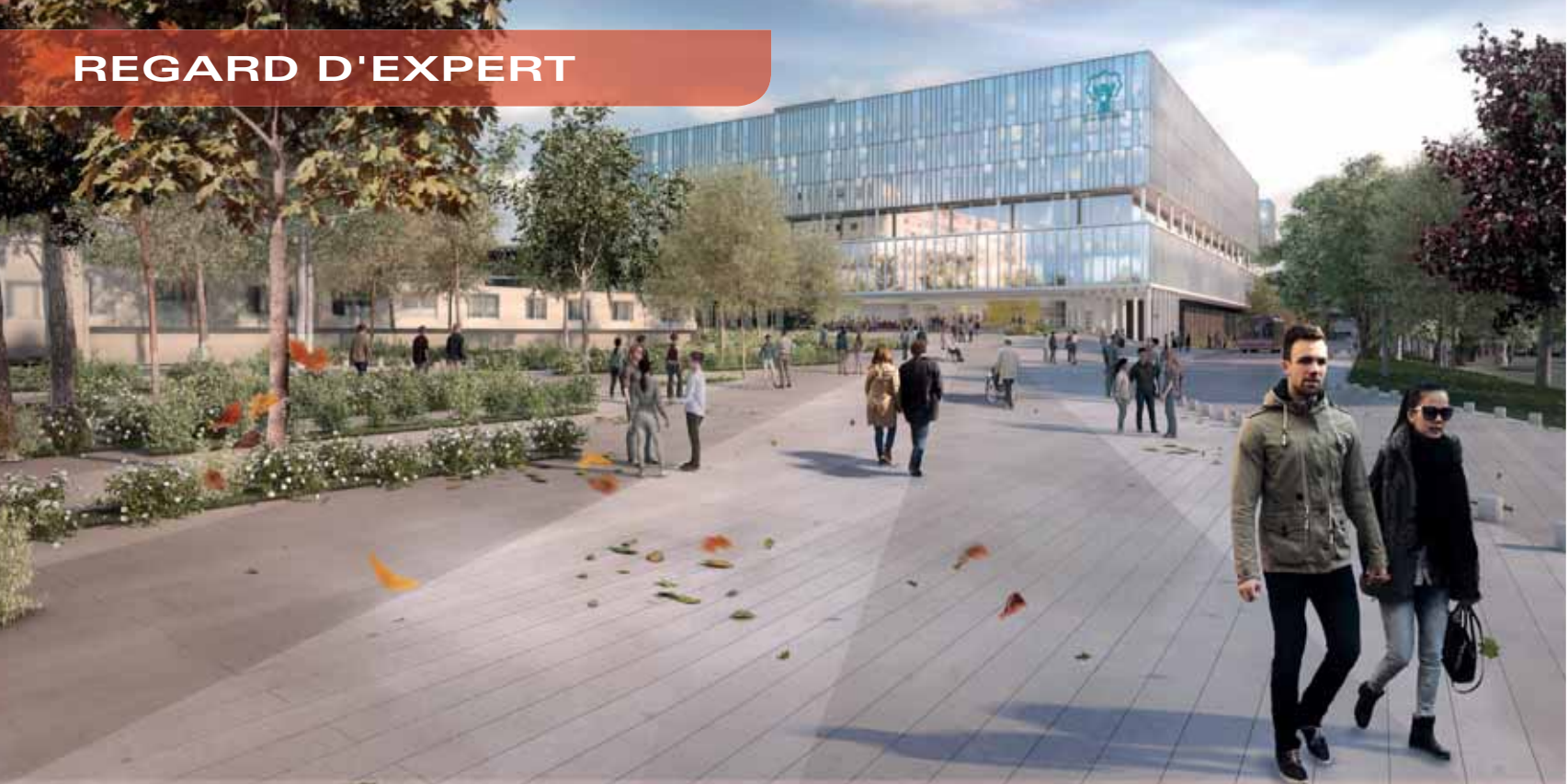
Nouvel hôpital de REIMS | © Groupe-6
