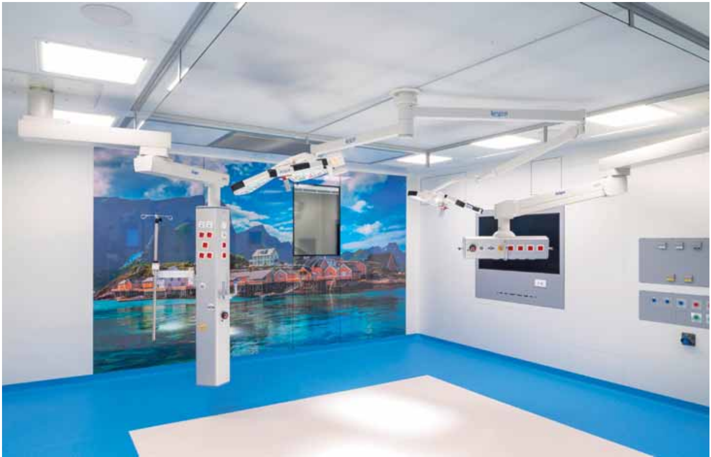
Bloc de l'hôpital de la Pitié Salpêtrière réalisé par l'entreprise La Salle Blanche
