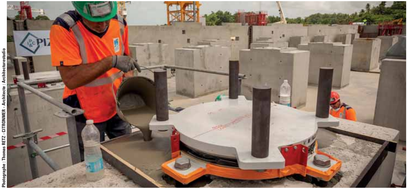
Pose des isolateurs sismiques
