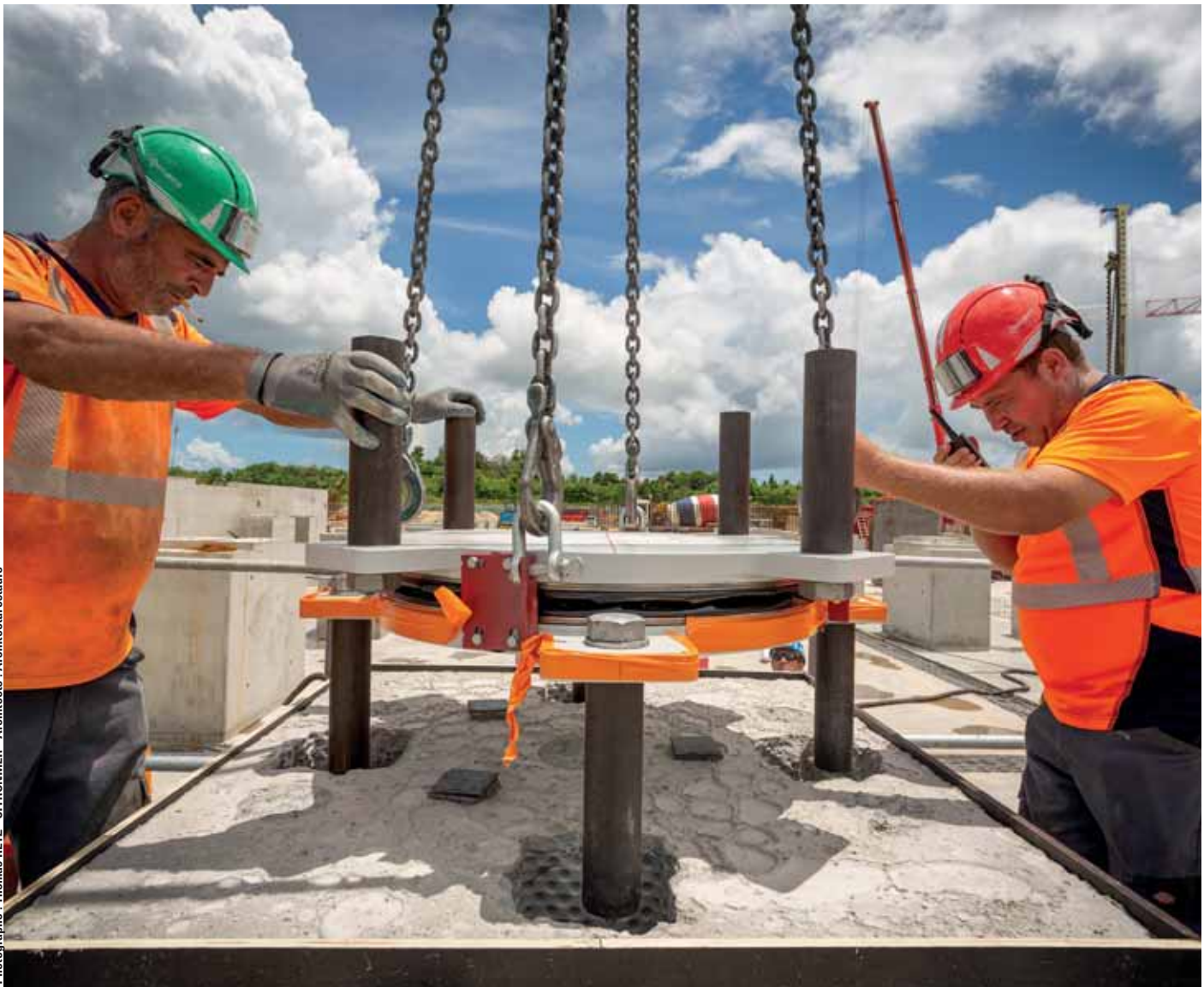
Pose des isolateurs sismiques
