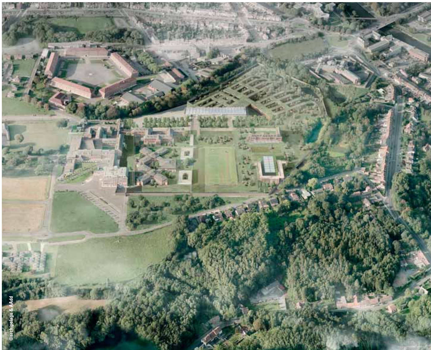
CRP Les Marronniers - Vue aérienne
