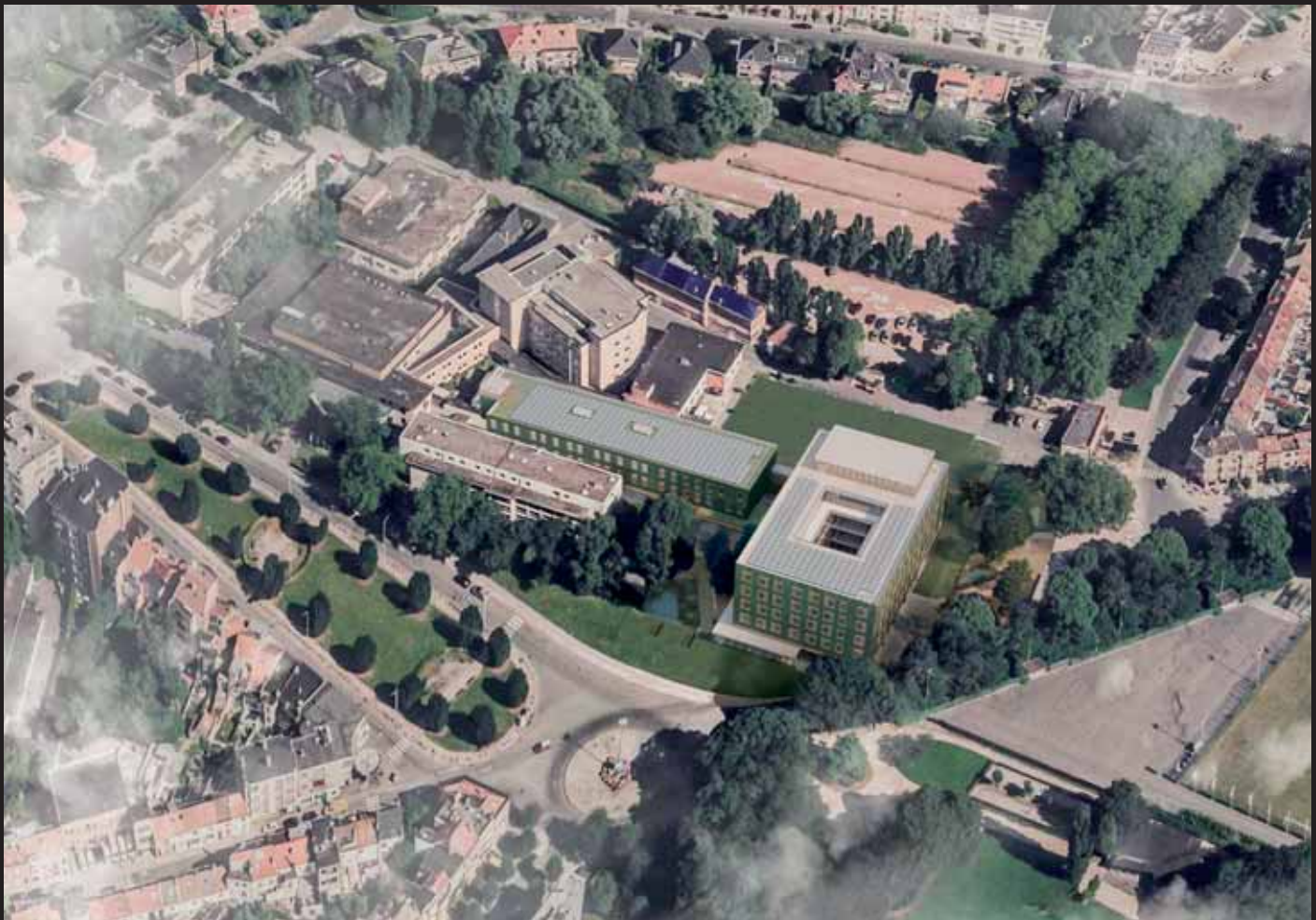
Constructions de la première phase (polyclinique et bloc médico-technique)
