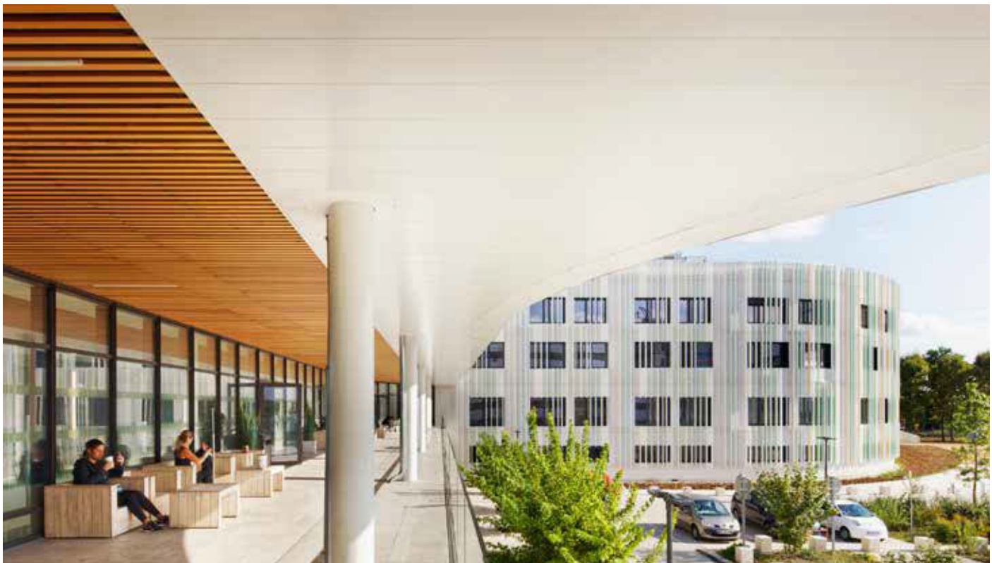
Hôpital Nord Ouest de Villefranche-sur-Saône - Pôle SSR, nouvelle entrée et extension du plateau technique - avec A+ Architecture mandataire ©Camille Gharbi
