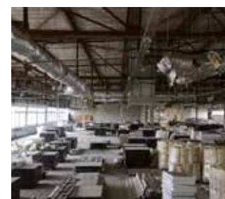
Extraction des éléments intérieurs de bureaux en vue du réemploi hors-site © Bellastock
