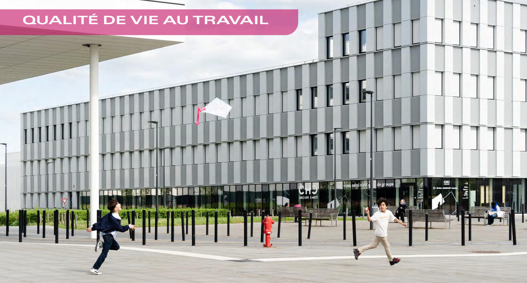
CHC Bâtiment Service de Groupe ©Gauthier Houba
