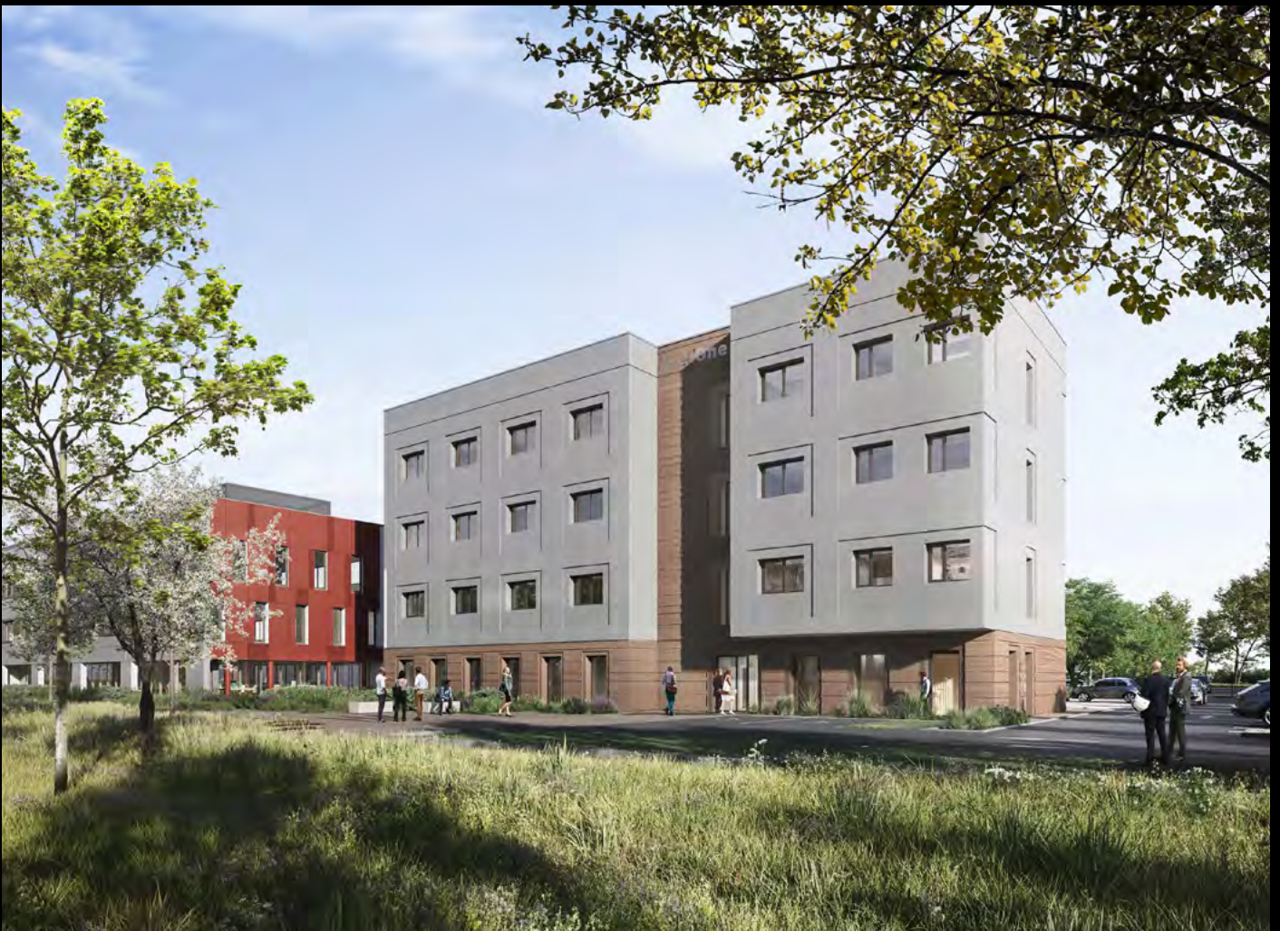
SERL – Plateforme AXEL ONE à Saint Fons – Chantier en cours - Image EXFOLIO
