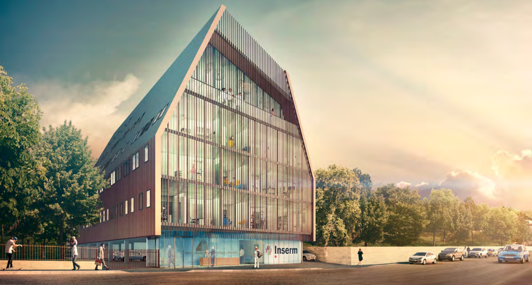
INSERM – Laboratoire Fight Cancer à Marseille – Chantier en cours – Image EXFOLIO
