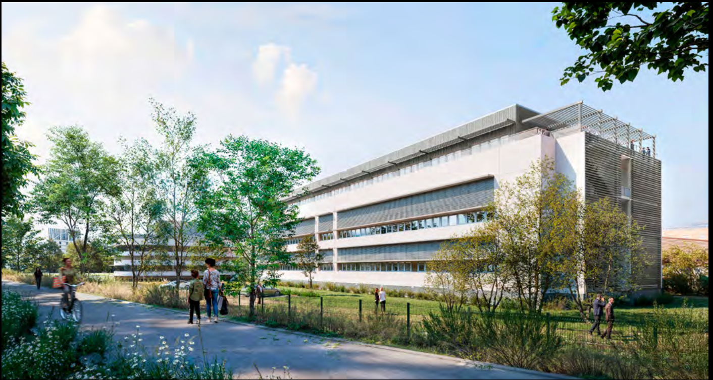
bioMérieux Grenoble – Laboratoire de Microbiologie – Chantier en cours – Image Besson
